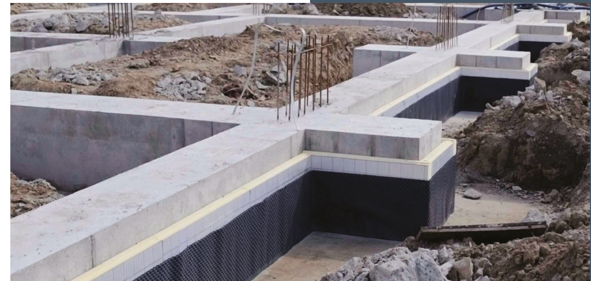
Ocieplenie fundamentów płytami izolacyjnymi
